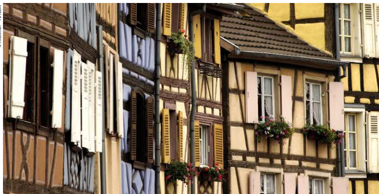
Façades d'une rue de Colmar
